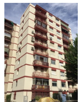
Aislamiento de edificios. Alcorcón
