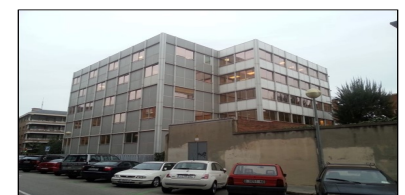
Nuevo sistema HVAC. Barcelona
